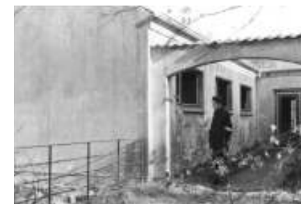
Besichtigung der renovierungsbedürftigen Gebäude
